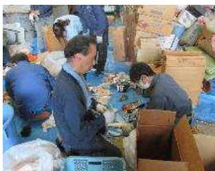
手作業で解体・分別します
