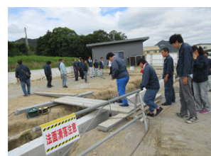
国分寺作業所増築工事見学
